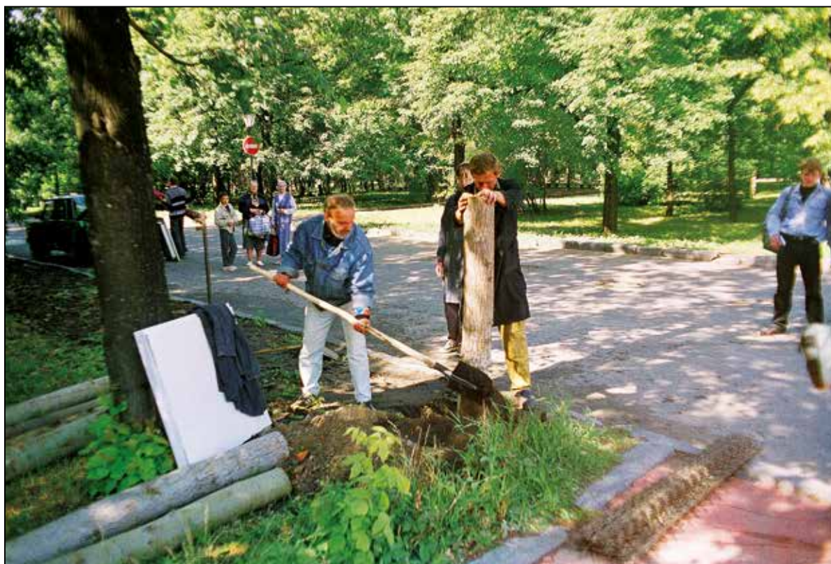
Освящение места раскопок и устройство ограждения. 29 июня 1998 г.
