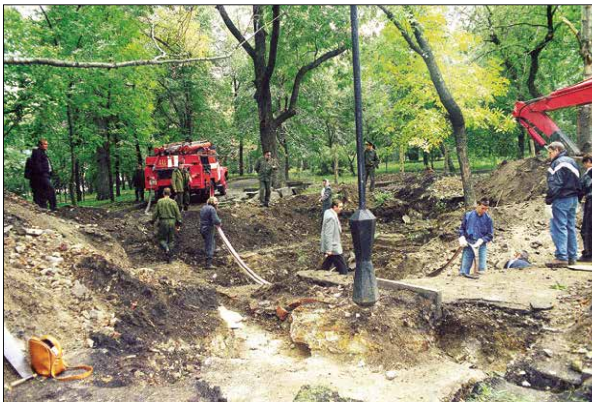
Откачивание воды из второго склепа. 1 сентября 1998 г.
