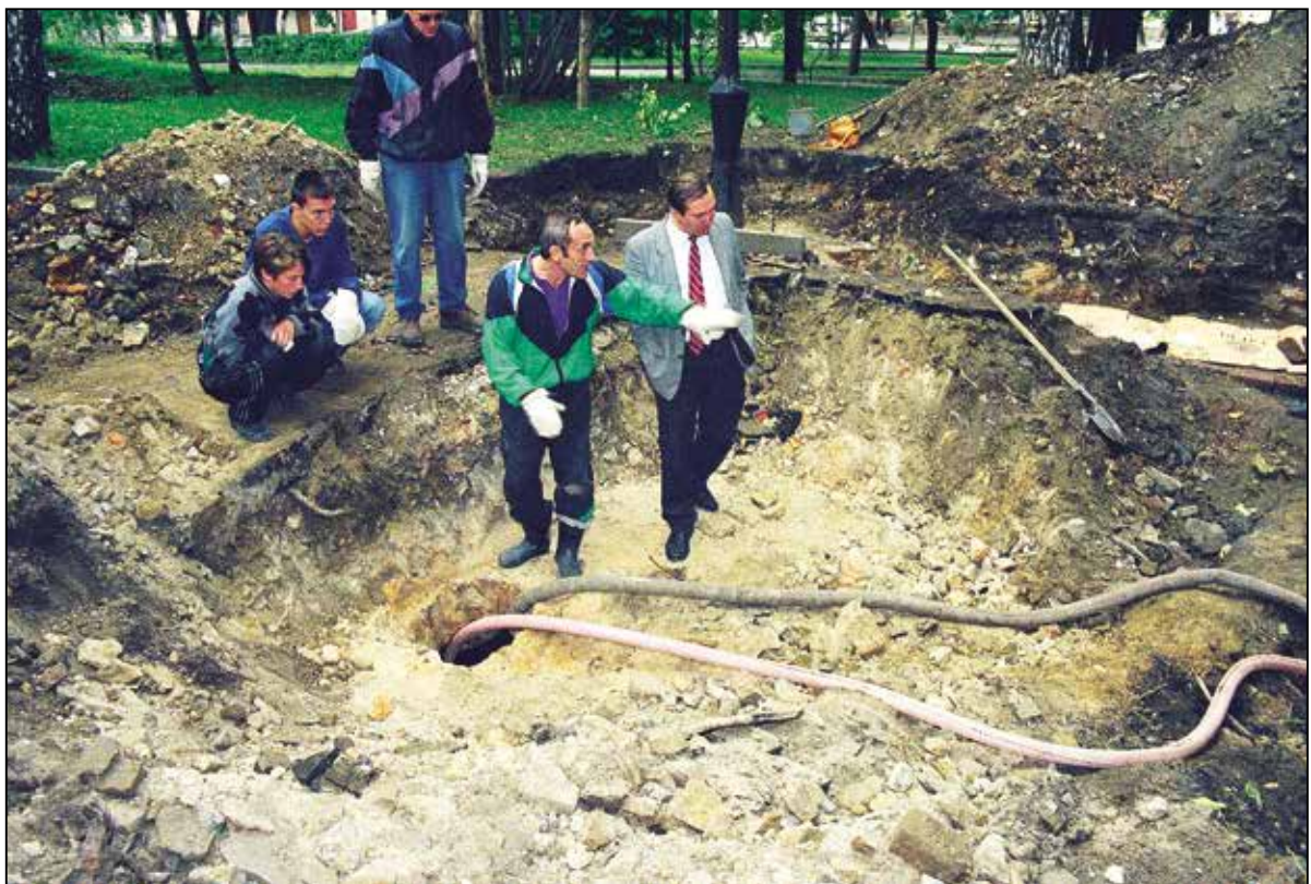
Откачивание воды из второго склепа. 1 сентября 1998 г.
